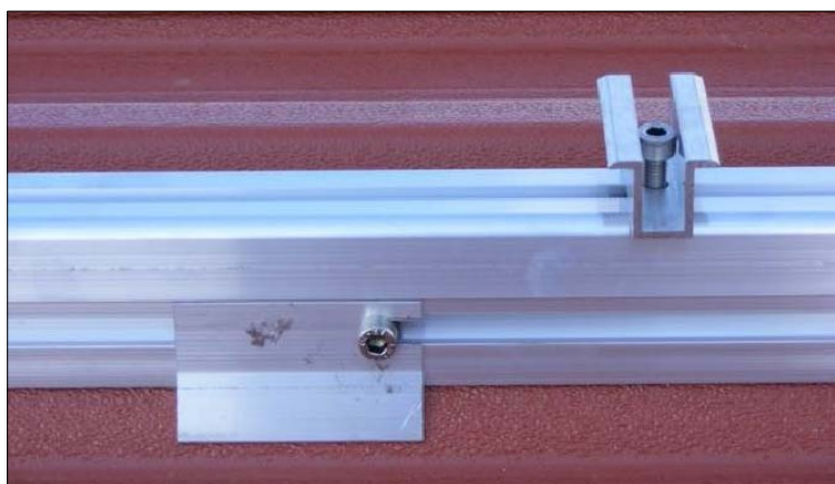
Montaggio Staffa di ancoraggio PCR, Profilato, Staffa intermedia
